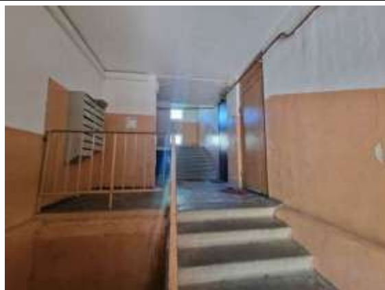
1.stāva kāpņu telpa
